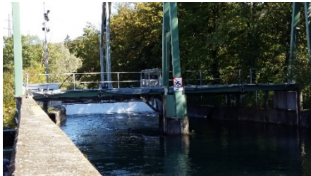
Das Wasserkraftwerk von aussen
